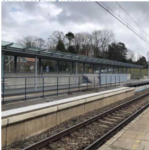
Luifel over nieuw perron en voorlopig perron
