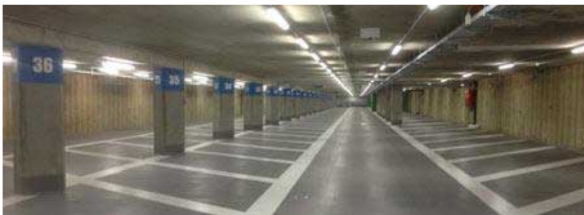
Intérieur parking Sud
