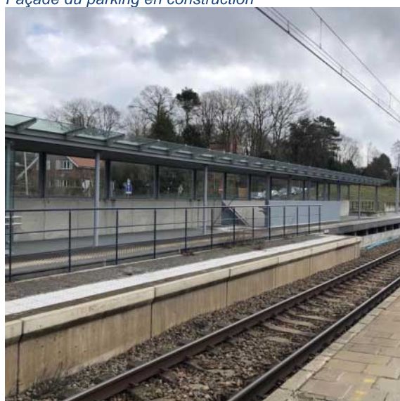
Auvent sur nouveau quai et quai temporaire
