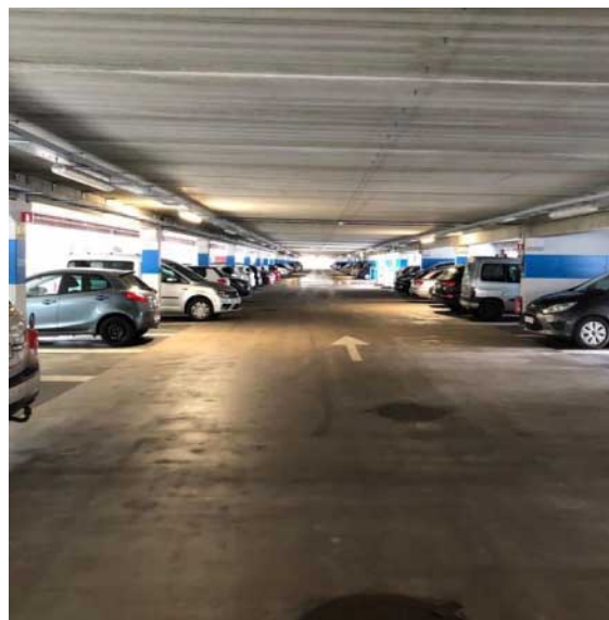
Intérieur du parking en service
