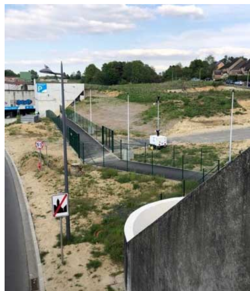
Terrein achter de sporen naar half- ondergrondse parking met verdiepingen Aantal reizigers per week (2022): 34485
