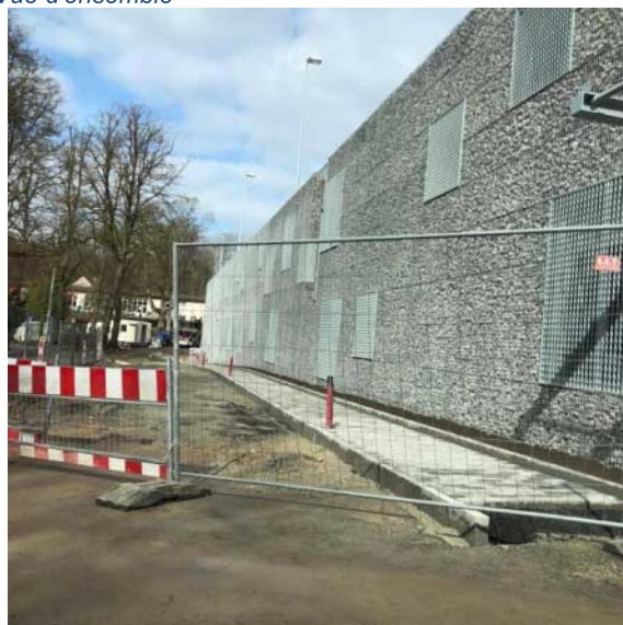
Façade du parking en construction
