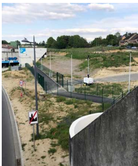
Terrain derrière les voies vers parking à étages semi-enterré
