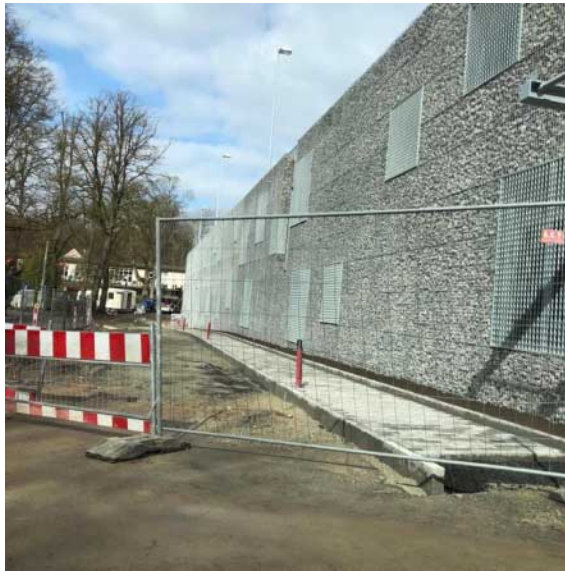
Gevel van de parking in aanbouw
