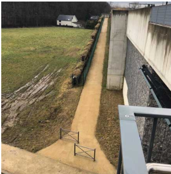
Toegangshelling naar het perron van spoor 2, bij de kruising met de Chemin de Bourgeois.
